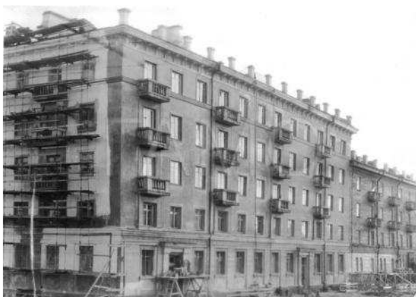
Строительство дома «Мурманрыбстроя» (Улица Пушкинская, 7. Крыло, обращенное к улице Профсоюзов). 1950 г. (ГАМО. Ф. Р-1310. Д. 2656)
